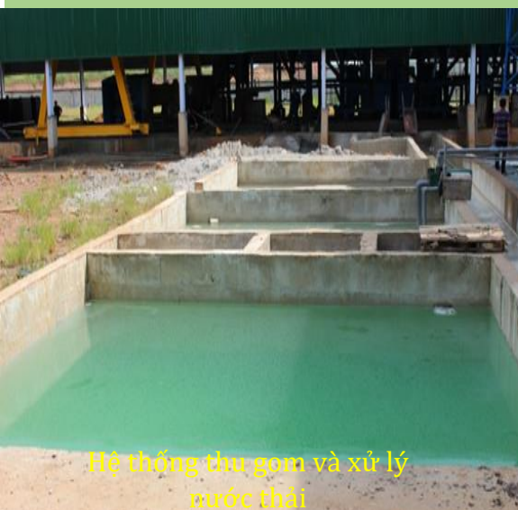
Hệ thống xử lý nước thải sinh hoạt
