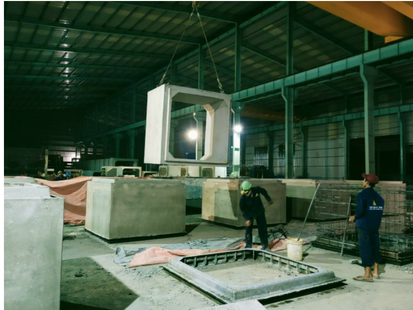
Sản xuất cống hộp công nghệ rung lõi
