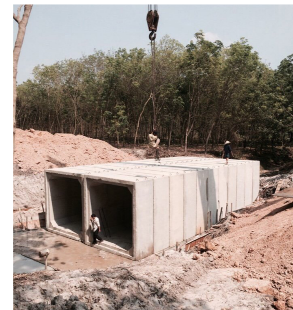
Công trường thi công cống hộp của CIC39
