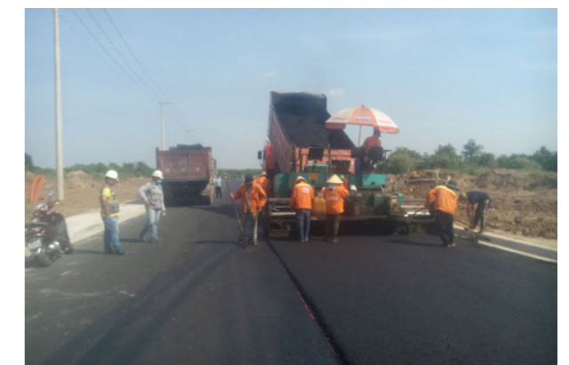
Công trình đường do CIC39 thi công
