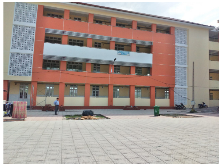
Công trình Lê Thị Trung do CIC39 thi công
